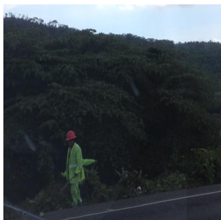
Limpieza del derecho de vía
