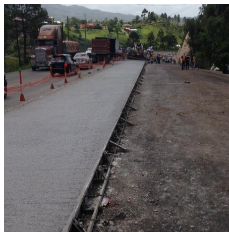
Trabajos de ampliación Siguatepeque y Taulabé
