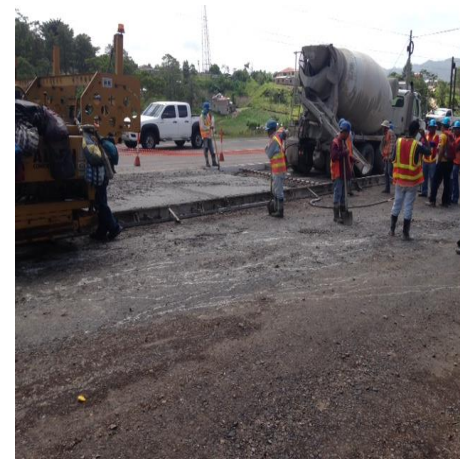
Trabajos de ampliación Siguatepeque y Taulabé
