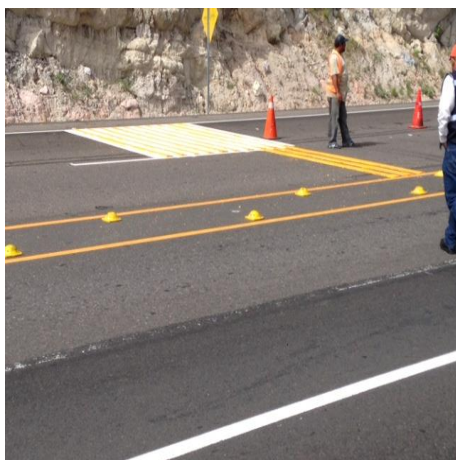
Trabajos de Señalización entre Fin del Valle de Comayagua y Siguatepeque
