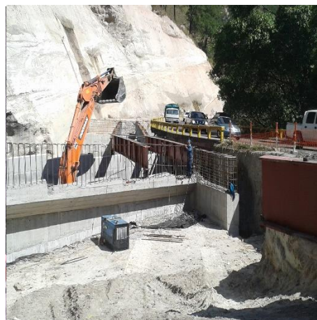
Colocación de Vigas Metálicas en Puente Calan I
