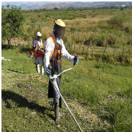
Trabajos de Mantenimiento Rutinario y Preventivo
