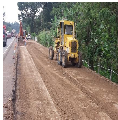
Trabajos de Movimiento de Tierra; Tramo: Taulabé – La Barca
